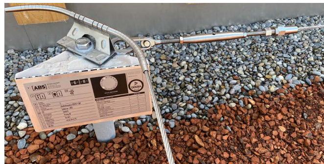
Abb. 43: Objektspezifische Kennzeichnung einer Seilanlage
