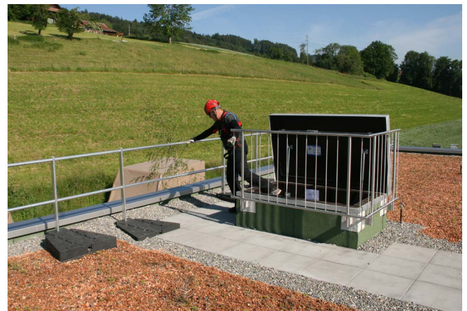
Abb. 36: Dachausstieg durch Seitenschutz aus dem Gefahrenbereich mit hoher Absturzgefahr gesichert. Optimal geplant würde der Dachausstieg in den inneren Gefahrenbereich führen
