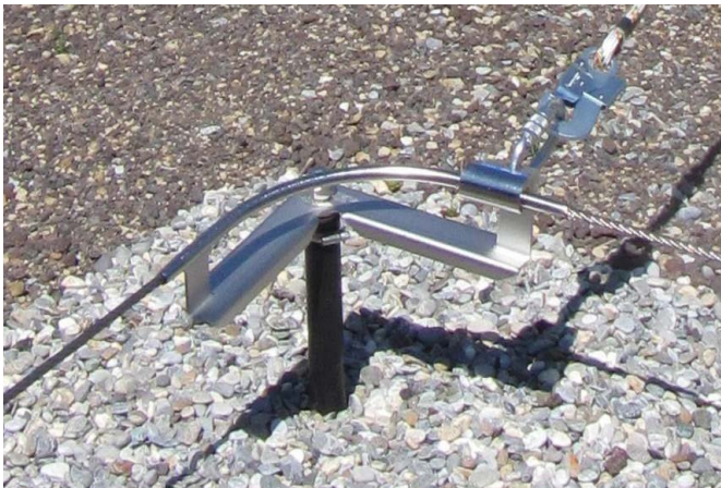
Abb. 17: Frei überfahrbarer Eckpunkt gemäss Herstellerangabe
